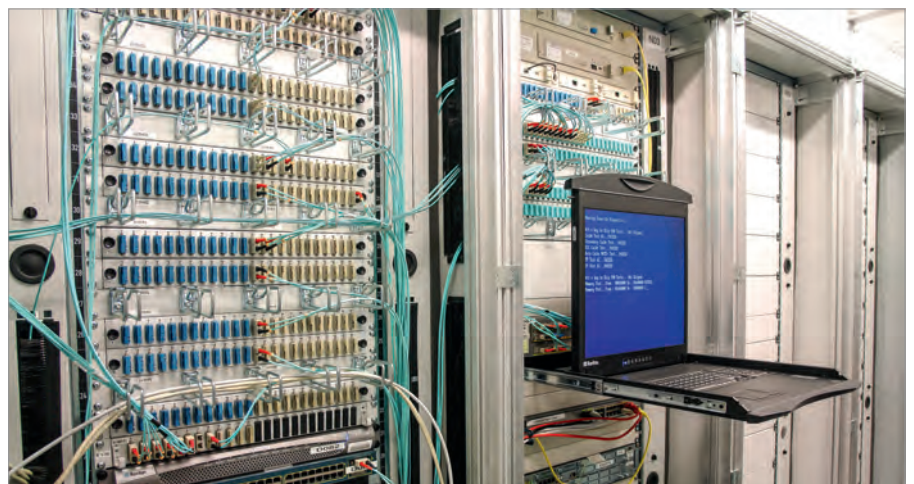
Serverkonsole für Wartungsarbeiten im Serverraum
